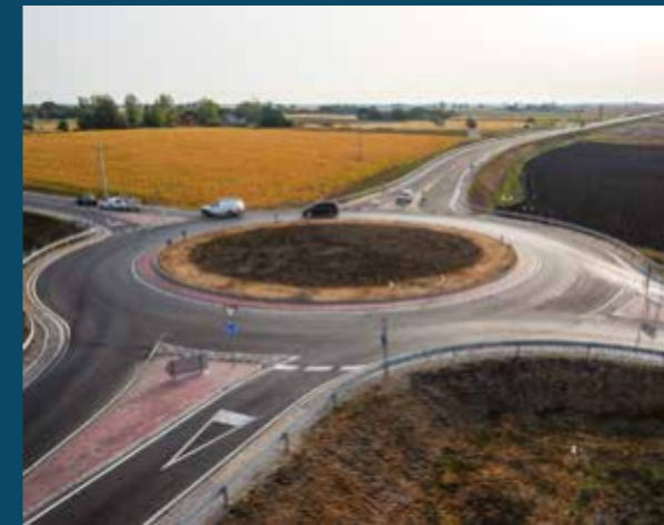
Jászberényi elkerülő Jászberény bypass road
