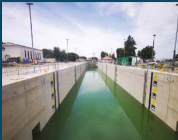
Balaton levezető rendszerének korszerűsítése Modernisation of the Lake Balaton water discharge system
