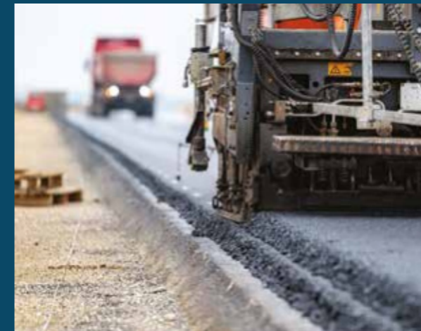
Sajószentpéter 260-as elkerülő építése Construction of bypass road 260 at Sajószentpéter
