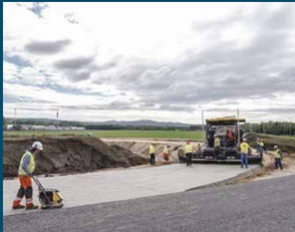
83. számú főút 2x2 sávra bővítése 2x2-lane upgrade of main road 83
